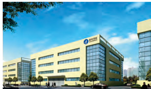
伺服电机生产基地（上海松江高科技园）
